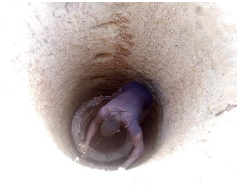
Revêtement des parois avec des cylindres en béton
