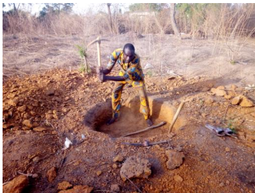
Construction d'un puits
