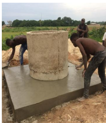
Margelle en béton
