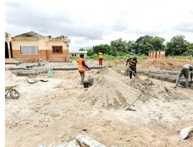
Production des blocs de béton sur site
