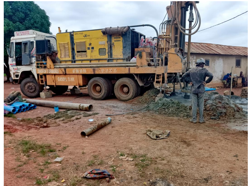
Mit einem Spezialfahrzeug wird auf 114 m Tiefe gebohrt.
