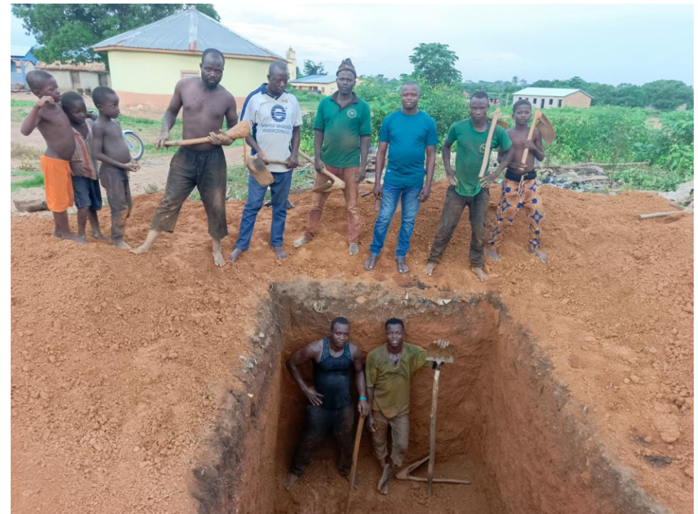
Beim Ausheben der Gruben für die Toiletten
