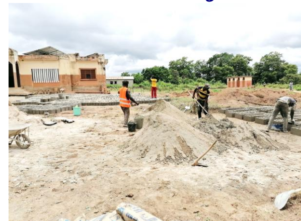
Herstellung der Betonsteine vor Ort
